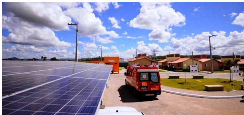
O empreendimento em Guarabira tem como diferencial a instalação de placas de energia solar fotovoltaica, que diminuem o custo da energia, para os idosos, em cerca de 80%
