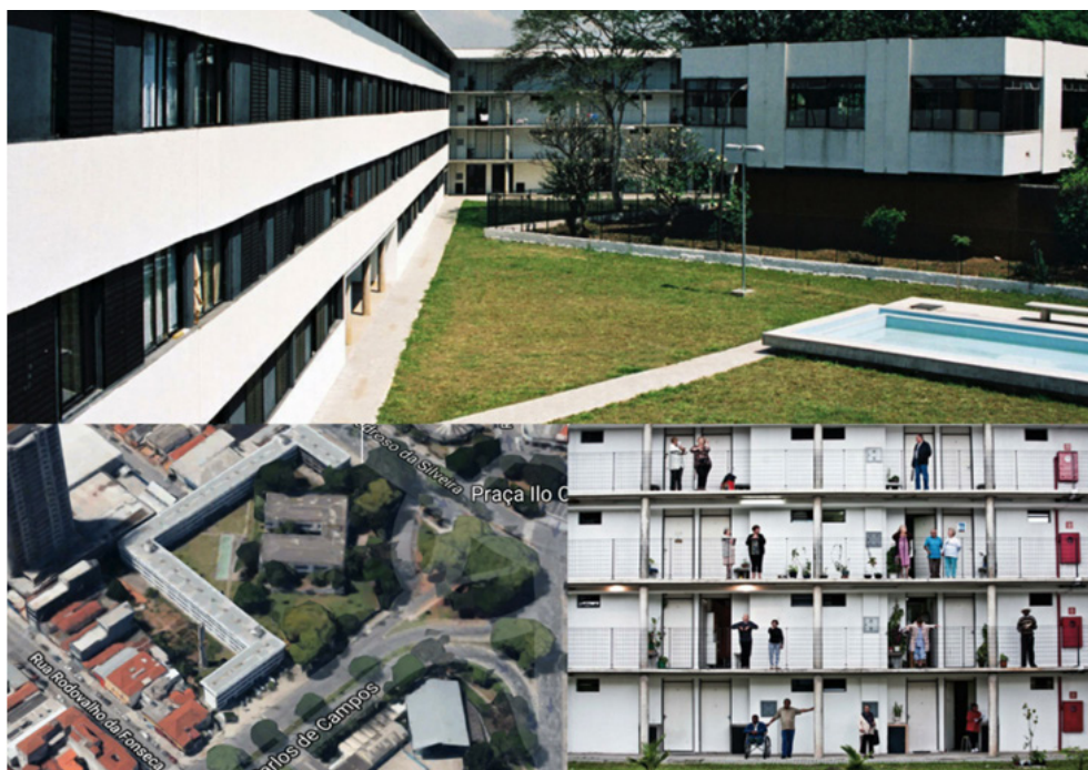
Imagem 3. Vila dos Idosos (visão lateral, fachada com idosos, visão aérea)
